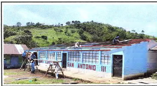
Foto 5: Cambio de techo del establecimiento en donde se observa el 50% de avance.
