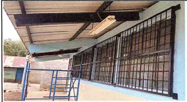
Foto 2: Vista lateral de la otra escuela en donde se puede notar el 75% del avance de la colocación de los otros 2 balcones.
