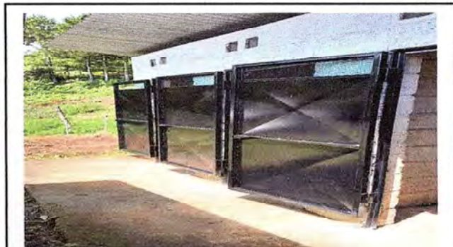
Foto 4: Se observa el 90% de avance de la colocación de las puertas de los sanitarios.
