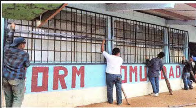
Foto 1: Vista frontal del establecimiento donde se puede notar el 75% de avance de la colocación de los balcones.
