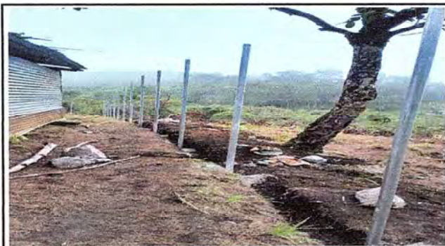
Foto 3: Se puede observar el 50% de avance de la circulación con malla y muro perimetral del establecimiento.
